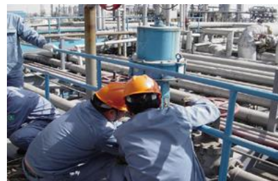
现场维护 Site maintenance
